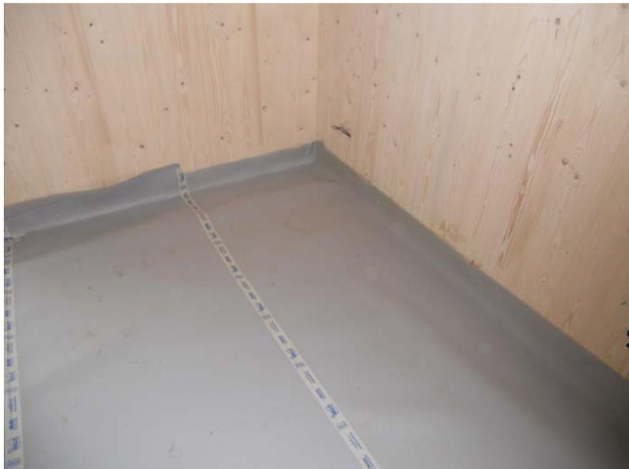
Couche d'isolant acoustique avant la pose de la chape au ciment. (Insulit Bi+5)
