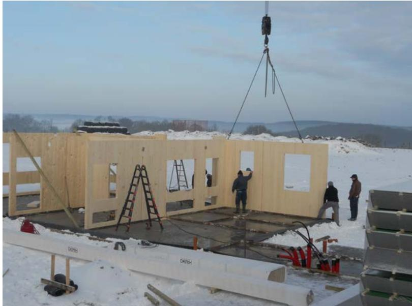
Pose des parois du rez de chaussée. Celles-ci étant chacune autoportantes de par leur nature propre de lamellé-collé, elles forment, une fois reliées ensemble, une structure extrêmement stable et solide.
