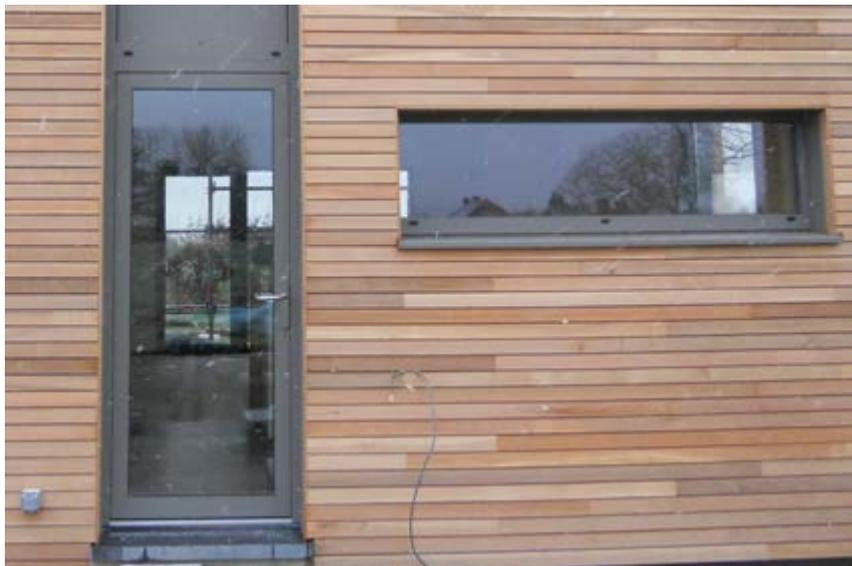
Châssis aluminium et double vitrage.
