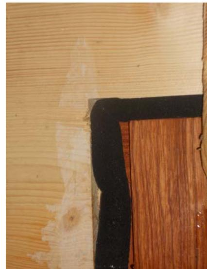
Une bande d'étanchéité à l'air gonflante est placée.
