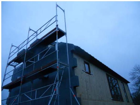
Exemple avec une isolation en EPS collée et fixée mécaniquement d'une épaisseur de 20cm (pour ce type d'isolant on peut aller jusqu'une épaisseur de 24cm) (système complet d'isolation ETICS – ici : Willco)
