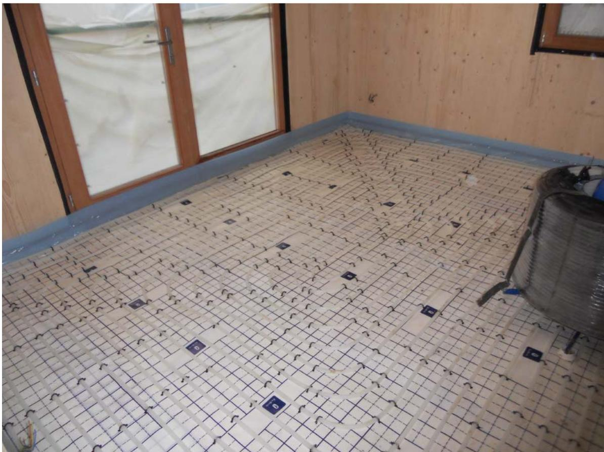
Pose des tuyaux de chauffage flexible sur la chape de polyuréthane.
