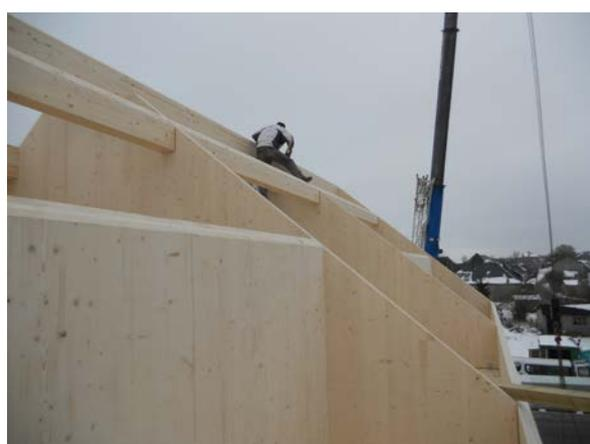
Mise en place de la faîtière et des poutres destinées à supporter les panneaux de toiture. Le tout s'emboîte parfaitement au millimètre près.
