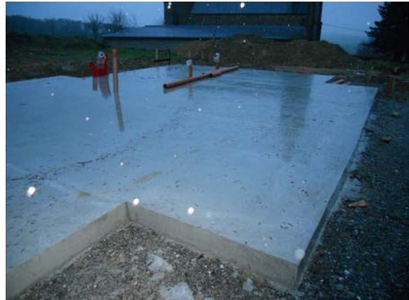
Les fondations et les éventuelles maçonneries de fondation sont réalisées ainsi que les gaines et fourreaux d'attentes destinées recevoir chacun des raccordements nécessaires (électricité, eau, gaz...)
