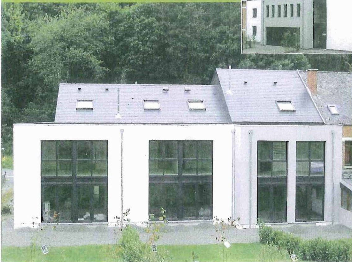
© Photos L'ÉPHOCÉ Architecture
